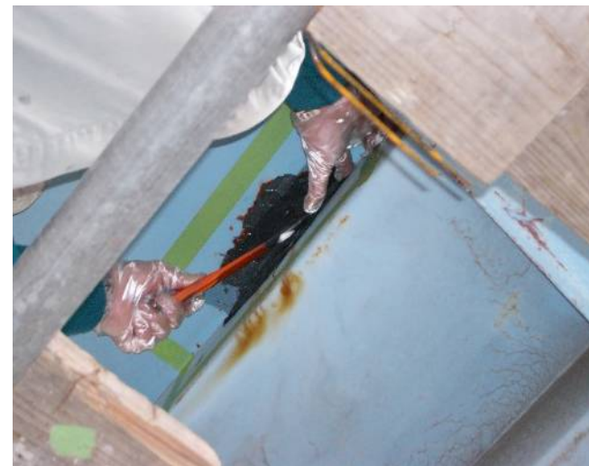
裏面 施工状況
