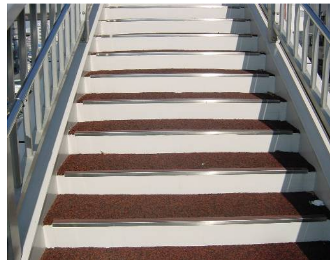
完成(ラストアップ塗布後塗装仕上げ)
