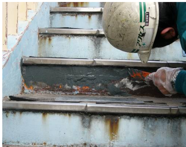
正面 施工状況
