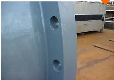
フランジ補修(施工後)
