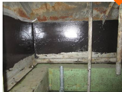
タンク内面孔食部(施工後)
