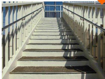
歩道橋階段蹴上部(施工後)
