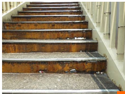
歩道橋階段蹴上部(施工前)
