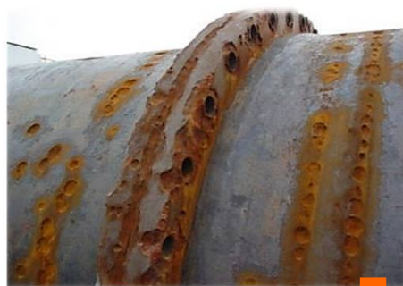
フランジ補修(施工前)
