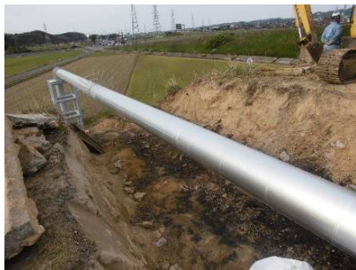
水管橋(施工後)
