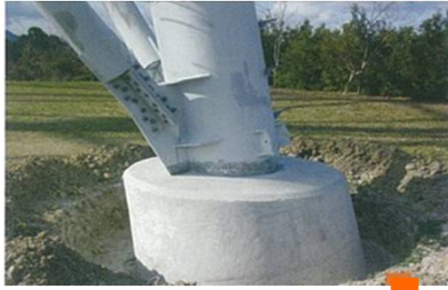
鉄塔基礎(施工前)
