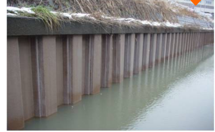
鋼矢板(施工後)
