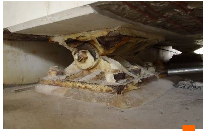
橋梁支承部(施工前)
