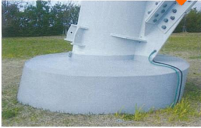
鉄塔基礎(施工後)
