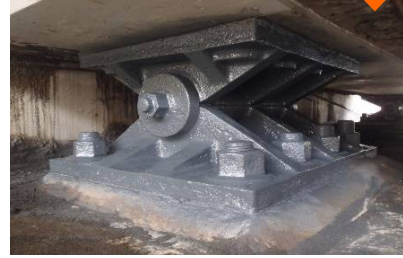
橋梁支承部(施工後)
