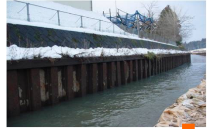
鋼矢板(施工前)
